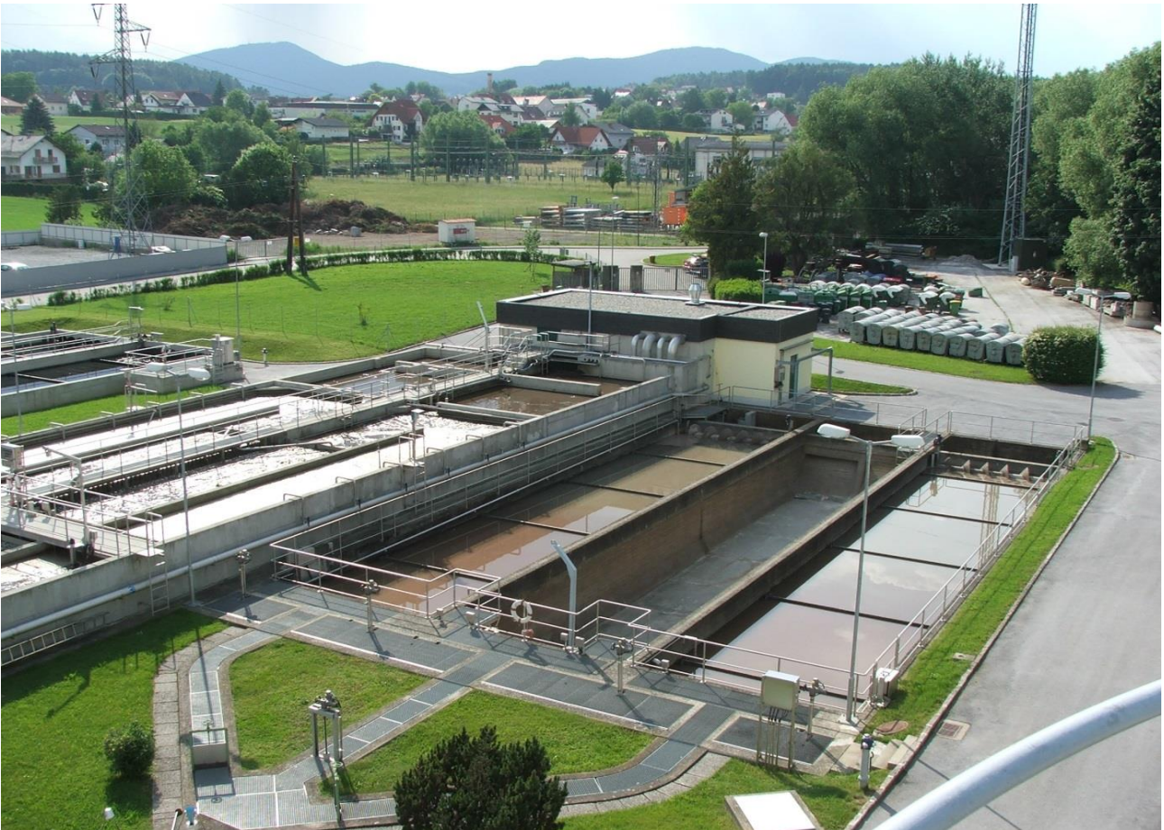
Kläranlage Weiz – Wärme­gewinnung zur Beheizung und Kühlung
