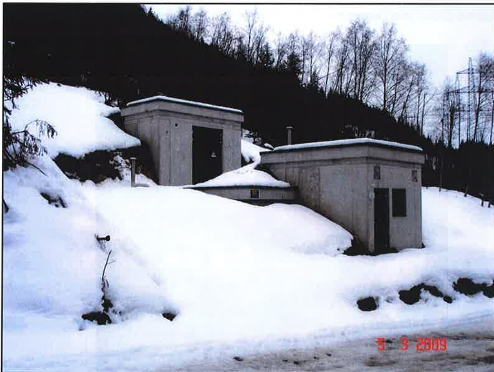
Abb. 2: Kraftwerkshaus Mühlbach/Bramberg. Die nötigen Gebäude können nach dem Gelände angepasst werden.
