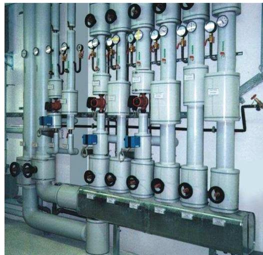
Bild: Fachgerecht gedämmte gebäudetechnische Anlage (Beispiel)
