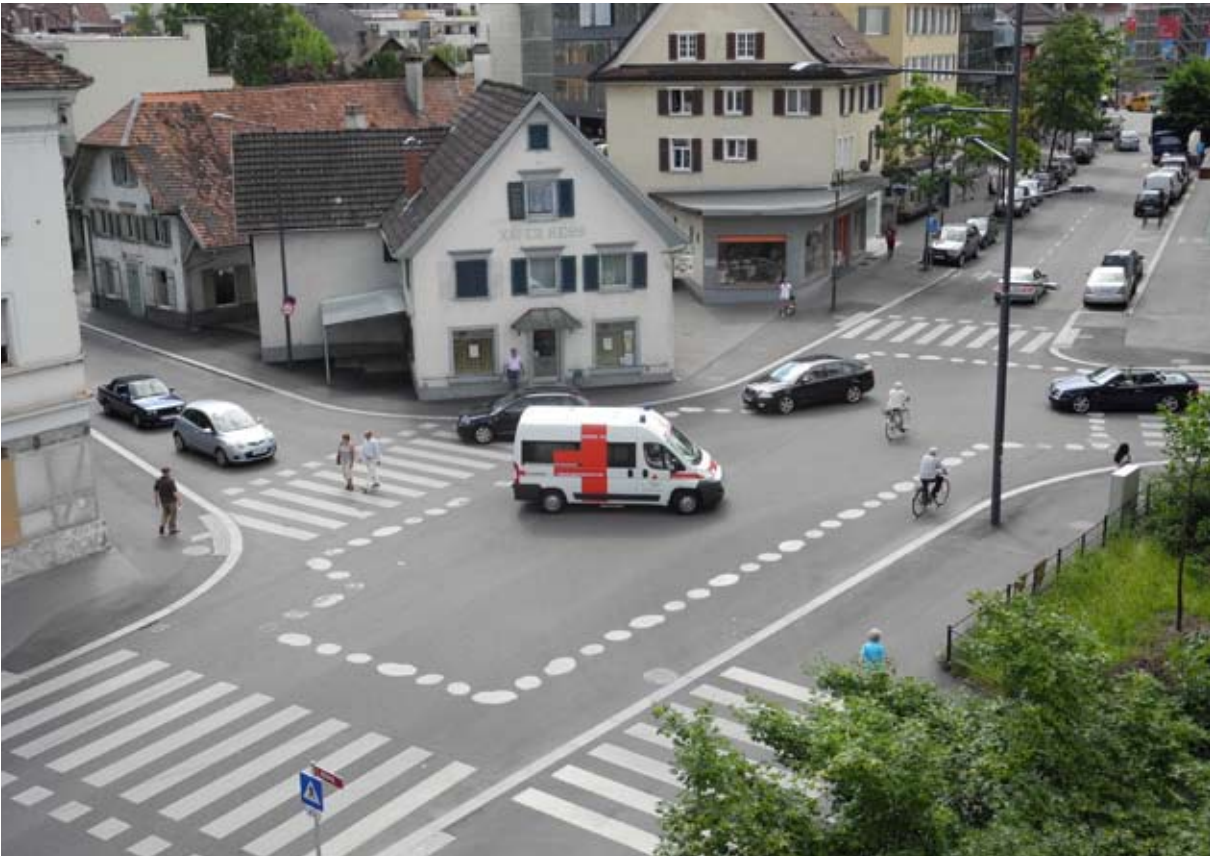
60 Die Luftbildaufnahme zeigt den neu gestalteten Kreuzungsbereich in Dornbirn Richtung Klostersgasse.
