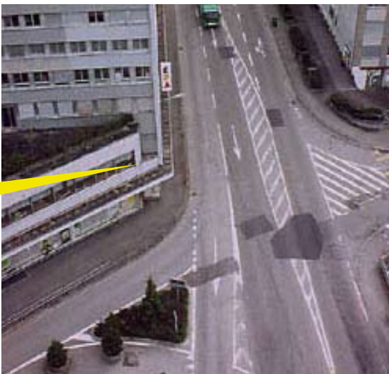
30 Grenchen, Schweiz, vor dem Umbau
