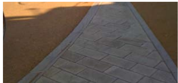
136 Die Fahrbahn und die Gehsteige sind farblich gleich, jedoch in unterschiedlichen Materialien gestaltet.
