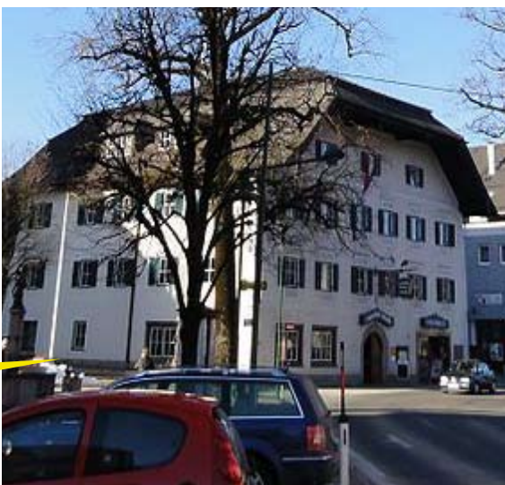
32 Thalgau, Österreich, vor dem Umbau
