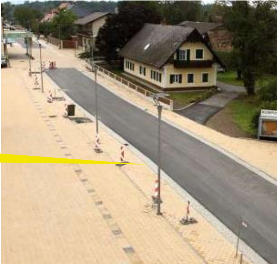
22 Optische Verschmälerung der Fahrbahn
