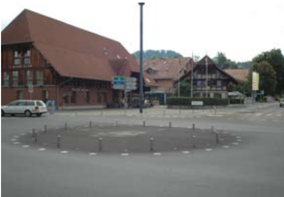
99 Der Kreisverkehr wurde mit Pollern definiert.
