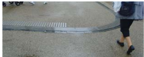
128 Schrägboards ermöglichen eine barrierefreie Begrenzung.
