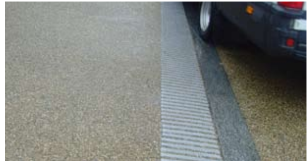
135 Die Fahrbahn und die Gehsteige sind im gleichen Material gestaltet.
