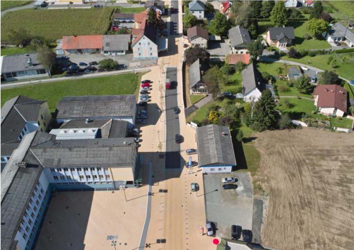
53 Das Bild zeigt den Übergang von der Landesstraße zur Platzsituation. Der gelbe Belag ist über den ganzen Straßenraum durchgezogen. Durch die optische Verschmälerung der Fahrbahn reagieren AutofahrerInnen mit einer Geschwindigkeitsreduktion.
