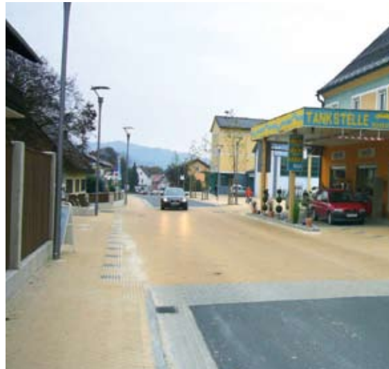
29 Gleinstätten, Österreich, nach dem Umbau zum Shared Space
