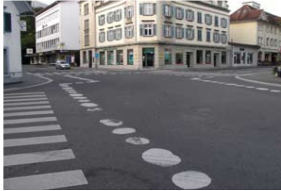
57 Der Kreuzungsbereich wurde als Shared Space umgestaltet.
