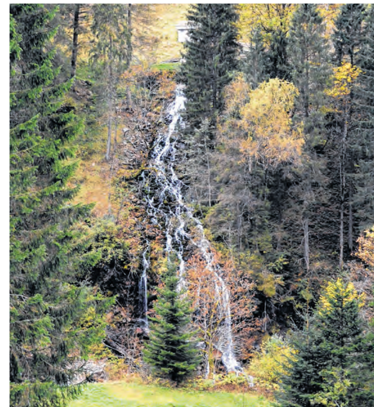
Die Wölfelnquelle entspringt im hinteren Fuschertal, ca. 80 Meter über der Fuschertal-Ache. Das Quelleinzugsgebiet erstreckt sich auf das Gebiet der Schmalzgrube. Im Bild: Quellfassung mit Überlauf.
